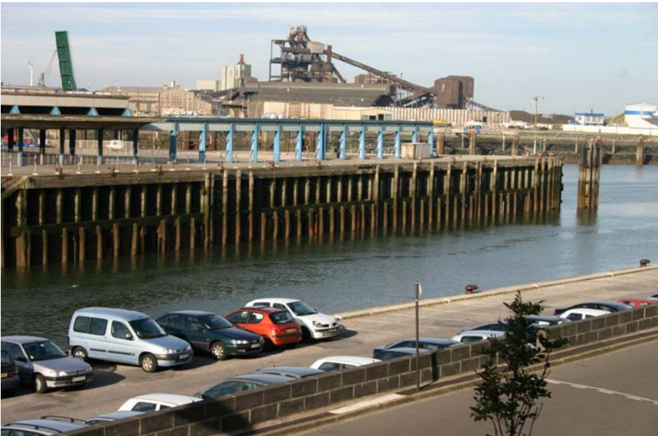
Photo des digues et quais dans la zone portuaire sur la commune de Boulogne (OTRA)
