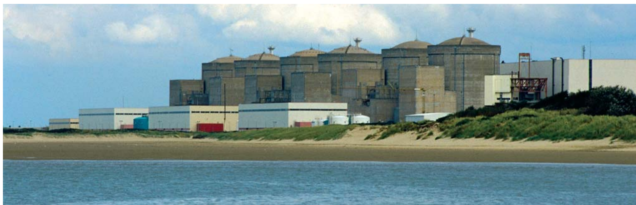
La centrale nucléaire de Gravelines.
