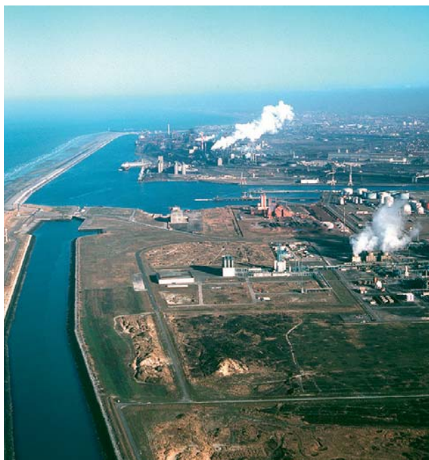
Vue aérienne de la zone industrielle du port de Dunkerque.
