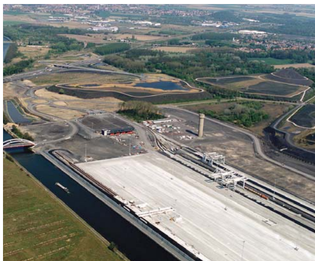
La plate-forme multimodale "Delta 3" de Dourges (avril 2003).
