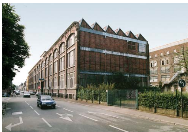
Friche Roussel à Roubaix avant réhabilitation.
