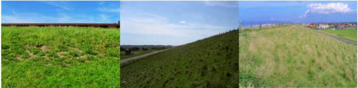
**Figure 29 : Le site pilote d'Hondsbosche présente trois types de défauts sur la couverture végétale en aval : une absence de végétation à certains endroits, des irrégularités en surface et une hétérogénéité de la végétation, source site Internet COMCOAST, 2005.**
