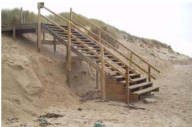
Figure 13 : Erosion d'un pied de dune à Oye Plage
