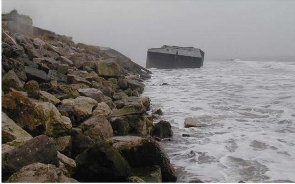
Figure 16 : Enrochement à Saint Gabriel dans le Nord de la Canche, source étude PPR Côtes Basses meubles du Pas de Calais réalisée par le Centre d'Etude Technique de l'Equipement (CETE) pour le compte du Service Maritime Boulogne et Calais (SMBC), 2006
