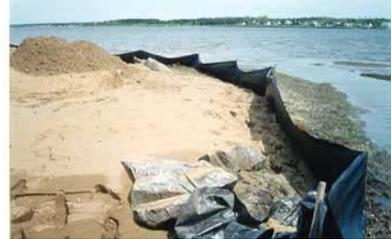
**Figure 19 : Un rechargement de plage, site Internet <http://www.gnb.ca/0263/coaststructure-f.asp>**
