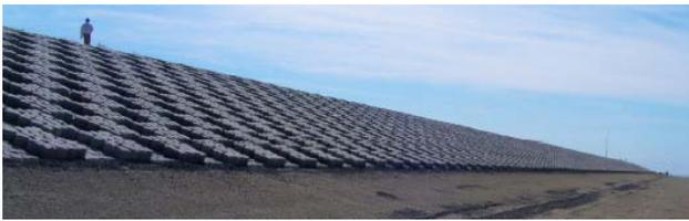
**Figure 28 : Protection en amont de la digue sur le site d'Hondsbosche, source site Internet COMCOAST**
