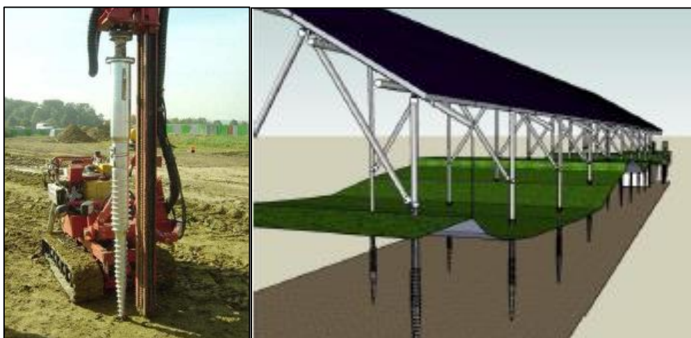
Figure 6 - Technique de fixation à l'aide fondation vissée dans la terre arable (Source : Krinner et Dhamma Energy)
