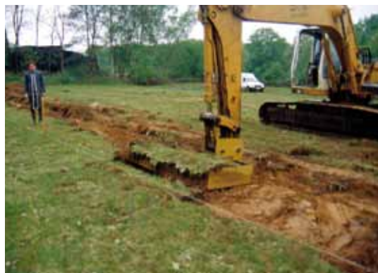
➤ Des banquettes de végétation sont déplacées par une pelle mécanique en vue de les redéposer sur le site désiré. Source : Ecosphère, mai 2001
