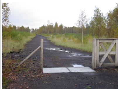
35 : Pas canadien, est un système sélectif ne laissant pas passer les animaux. Système utilisé pour laisser circuler les usagers dans les zones pâturées (G. Lemoine)
