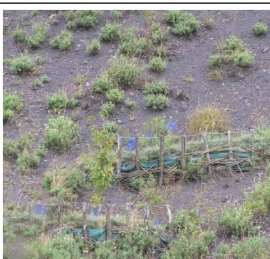
30 : Fascinage sur une pente pour limiter les éboulements (MBM)
