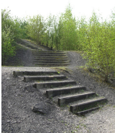
27 : Emmarchement à section rectangulaire (MBM)
