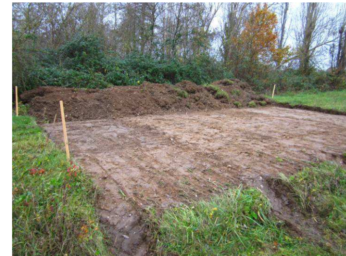
Exemple de décapage d'une zone d'accueil avec stockage des terres décapées (Source : © Thévenin OGE)
