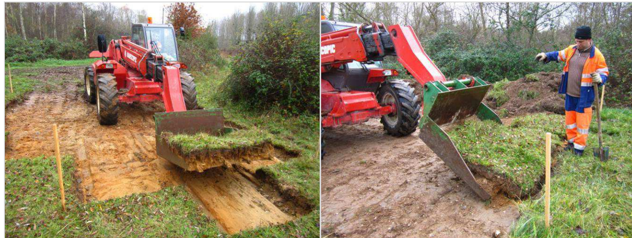
Prélèvement et remise en place de plaques de végétation (Source : © Thévenin OGE)
