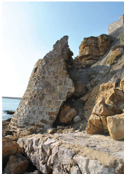
La construction peu à peu se décroche de la falaise.
