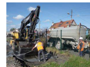
Nettoyage d'un engin sur une aire de lavage suite au décaissement d'un massif de Renouée du Japon
