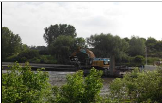
Pelle hydraulique sur ponton
