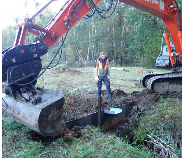
Restauration de seuils - MH. Guislain
