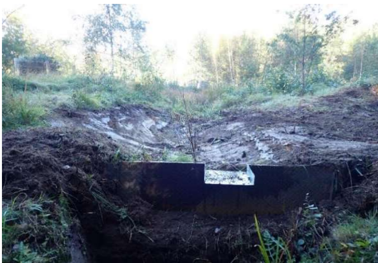
Figure 9 : Mise en place du seuil à l'aval direct de la mare à Zouzou le 14 octobre 2021
