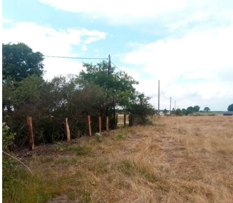
Pose de clôture - M. Georges
