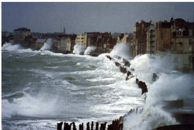
Figure 3-3: Exemple de franchissement de perré
