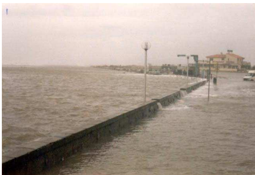
Figure 3-1 : Exemple de débordement de la mer
