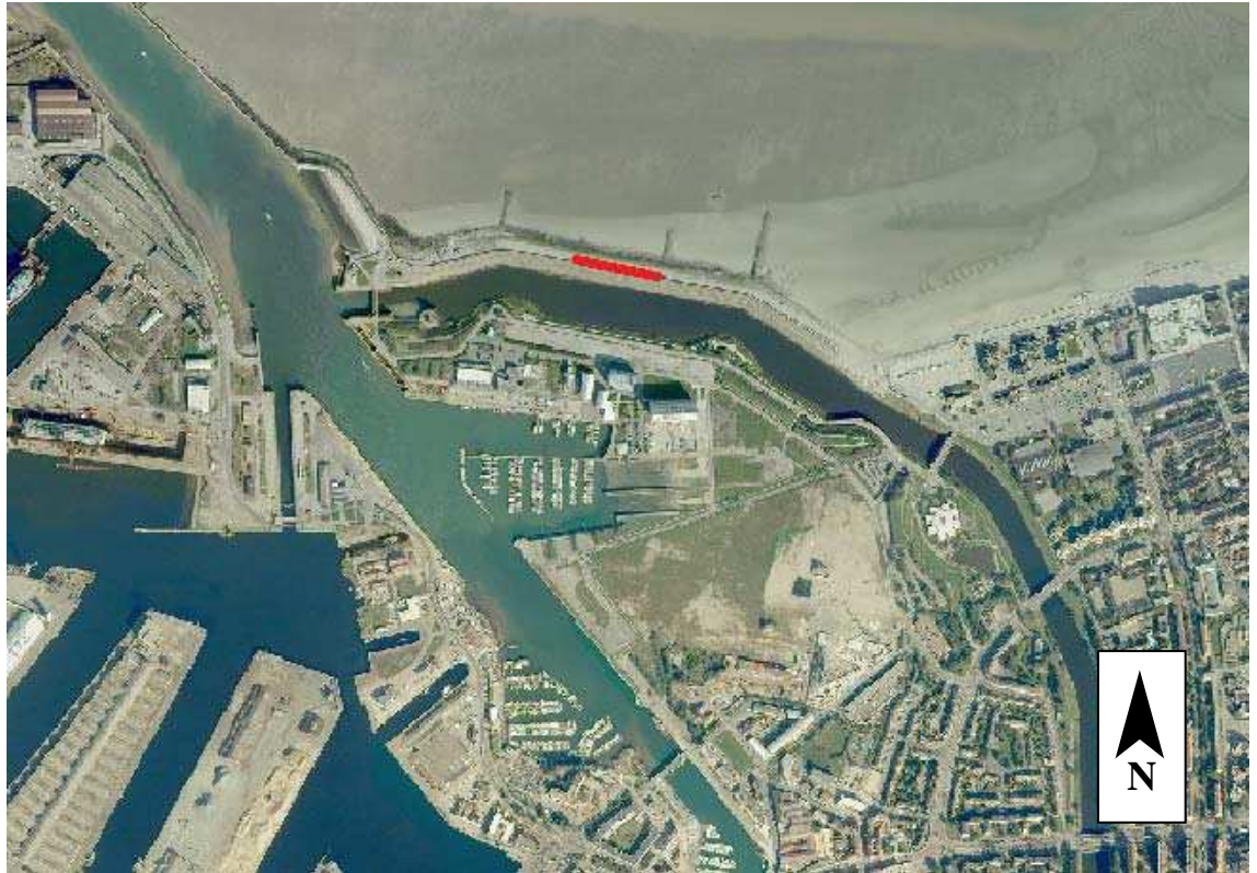
Figure 8-59 : Position de la brèche dans la digue des Alliés
