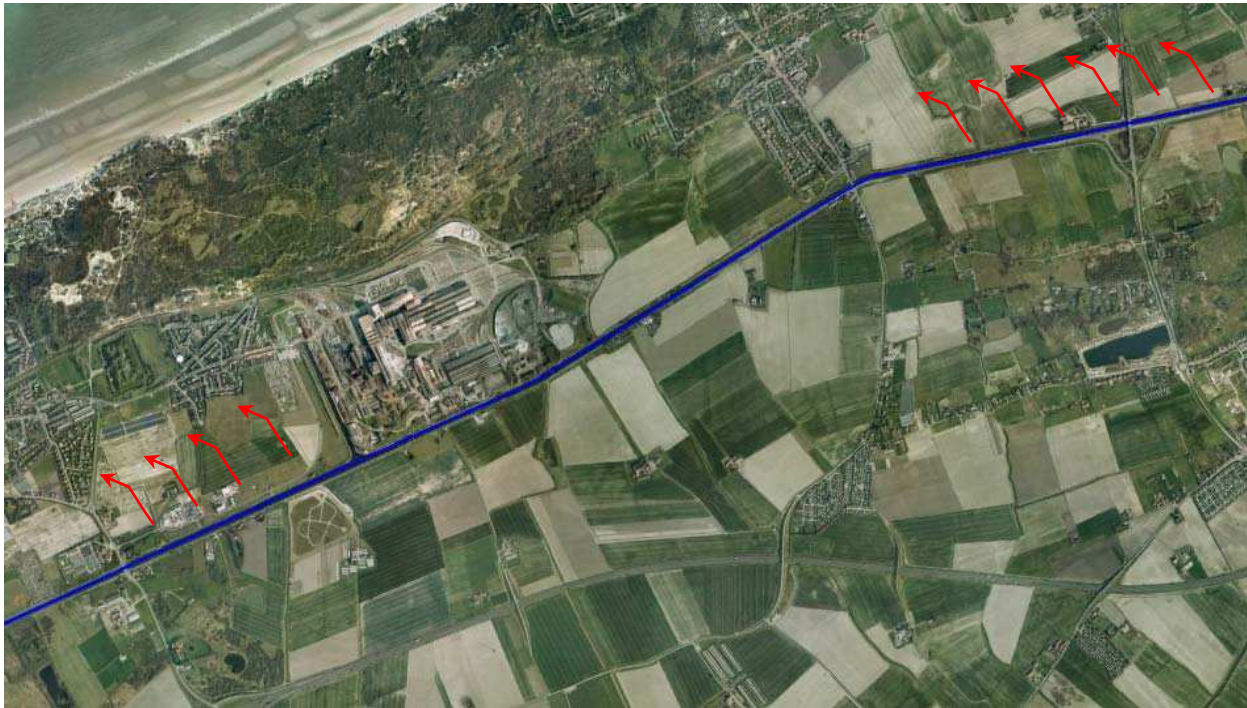
Figure 8-68 : point de sortie en rive gauche du canal de Furnes
