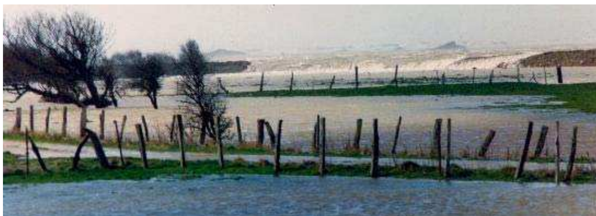
Figure 3 : En haut à gauche : Plan de situation [Source : pagesjaunes.fr]. En haut à droite : Vue aérienne des Bas-Champs inondés [Source : Le littoral des Bas-Champs soumis aux risques perpétuels d'inondation]. En bas : Digue des Bas-Champs submergée et érodée en pleine tempête [Source : cayeux-citoyens.asso-web.com].
