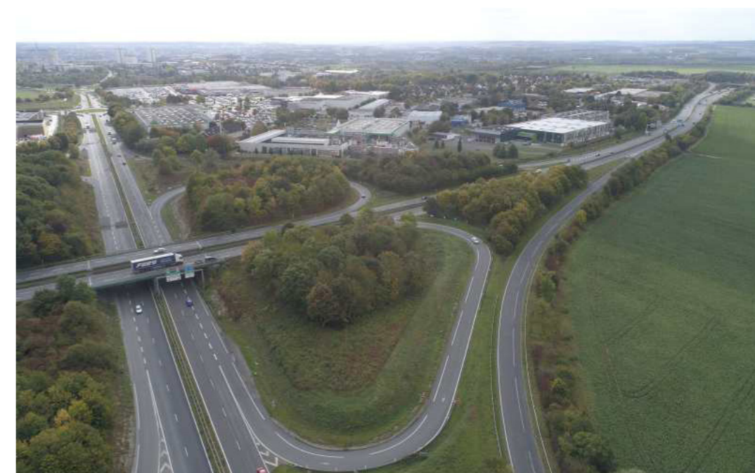
Figure 3 : Vue de l'échangeur Nord d'Amiens depuis la RN25
