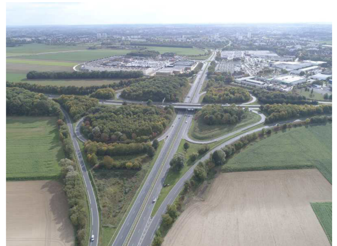
Figure 2 : Vue de l'échangeur Nord d'Amiens depuis la RN25
