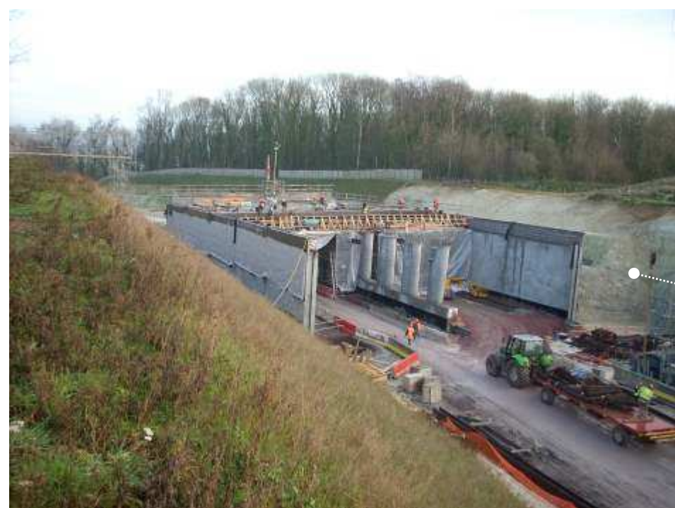
Tranchée couverte n°6
