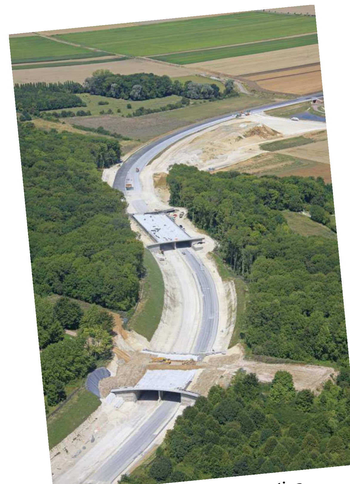
Tranchées couvertes en construction
