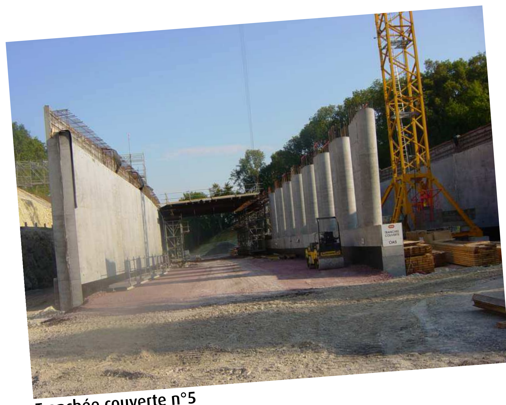
Tranchée couverte n°5
