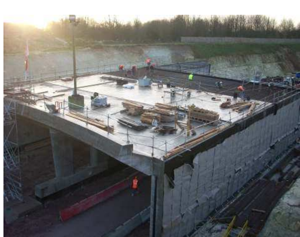
Tranchée couverte n°5
