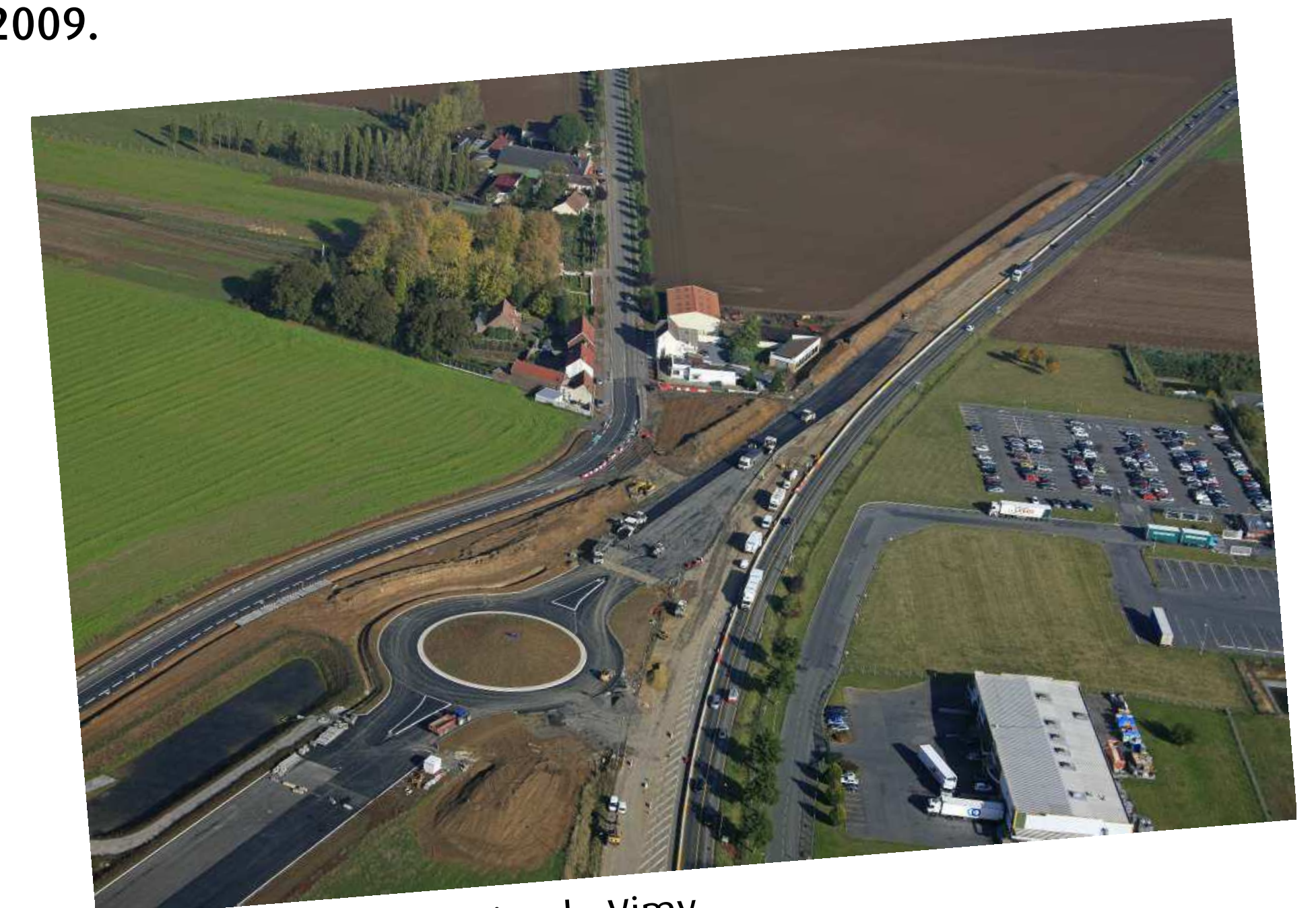
Construction du giratoire de Vimy
