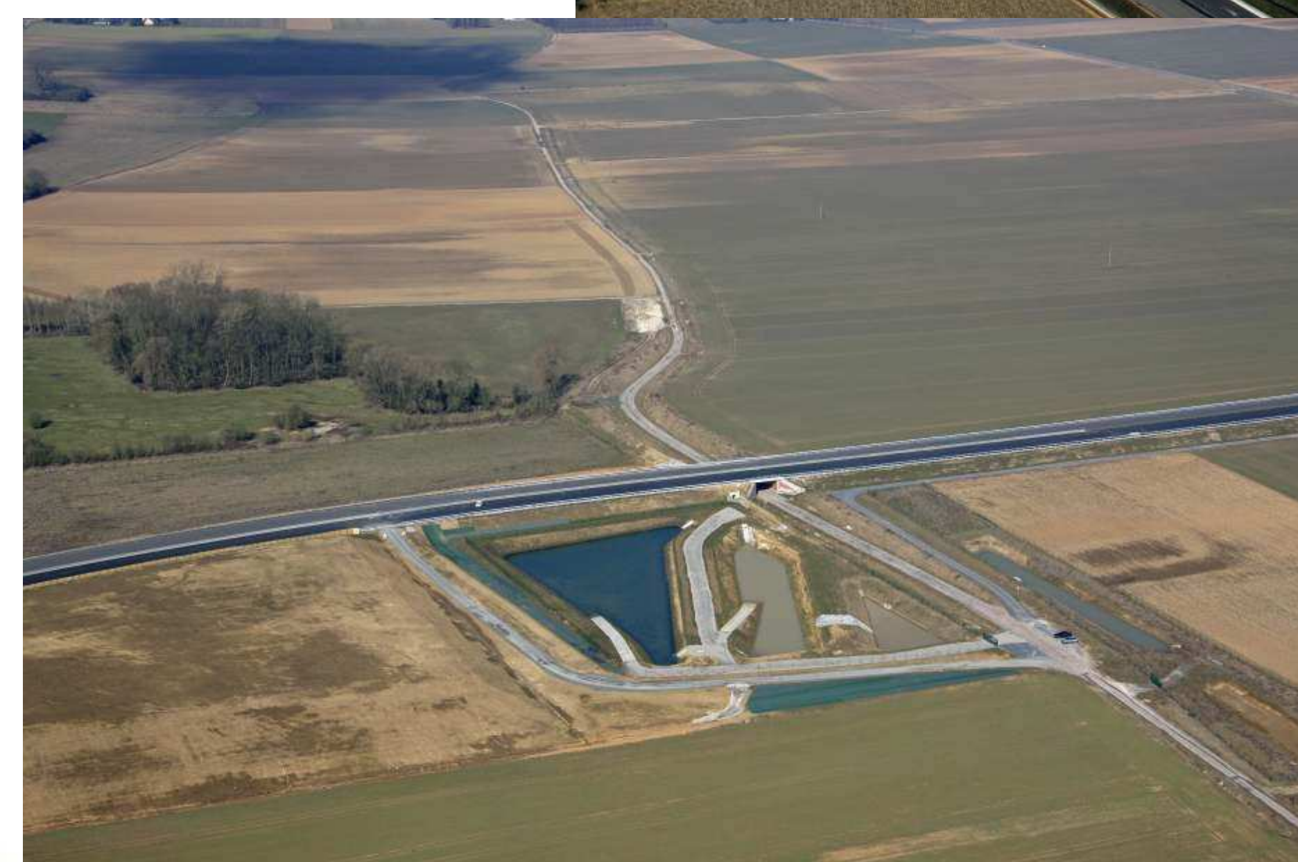
Dispositif de bassins décanteur/déshuileur étanches + infiltration
