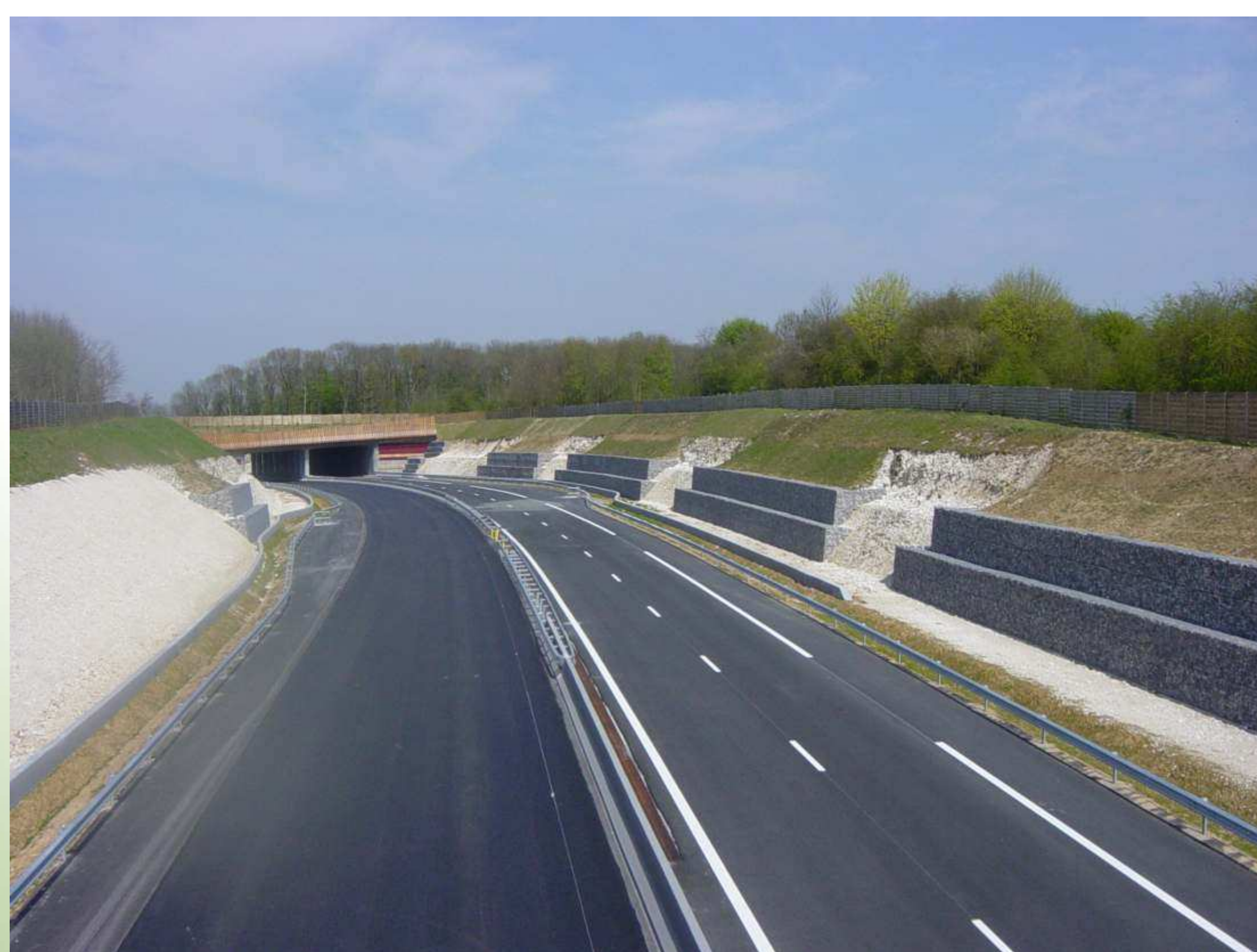
Insertion des murs en gabion
