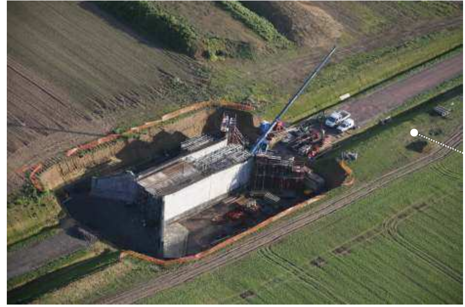
Ouvrage d'Art 7 lors de sa construction
