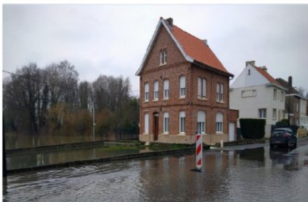
Photographies (source: SYMSAGEL): route inondée pendant l'épisode de fin janvier
