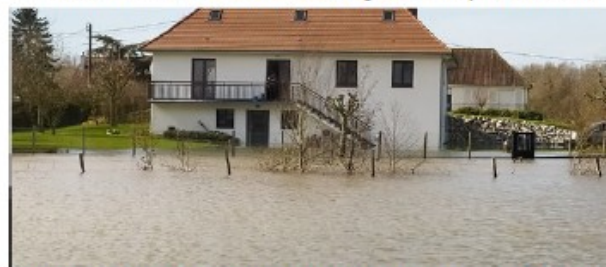
Photographies (source: DREAL) : D bordements de la Canche   Brimeux au cours de l' pisode de janvier 2021
