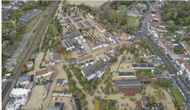
Photographies aériennes par drone (source : Philippe Lecocq Photographies / SYMSAGEB) : Inondations d'un quartier à Saint-Étienne-au-Mont à l'aval du bassin.
