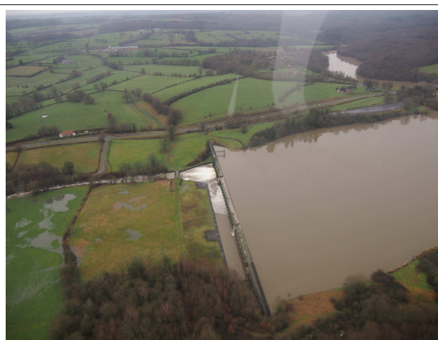
Le barrage du Val Joly sur l'Helpe Majeure en surverse (source : préfecture 59)
