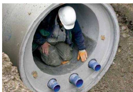
Figure 16. Canalisation préfabriquée avec échangeur de chaleur intégré (Source : Guide pour les maîtres d'ouvrages et les communes, OFEN)
