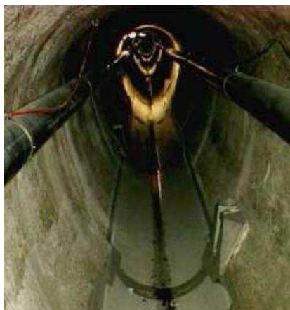
Figure 17. Échangeur installé dans un ovoïde existant (Procédé Rabtherm), échangeur pour collecteur existant (Procédé Uhrig)
