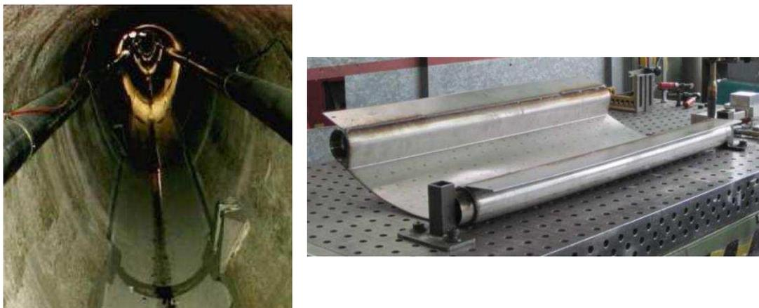
**Figure 17. Échangeur installé dans un ovoïde existant (Procédé Rabtherm), échangeur pour collecteur existant (Procédé Uhrig)**
