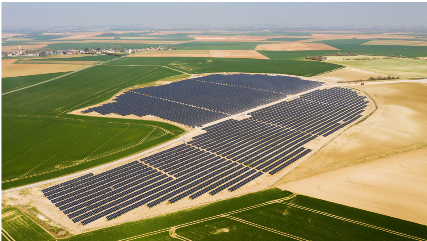
Centrale solaire Athies-Samoussy (Aisne - 02) Crédit photo : Sylvain Prémont
