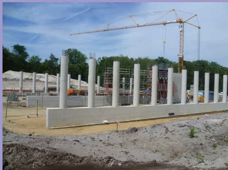
Passage faune de Tillet en construction
