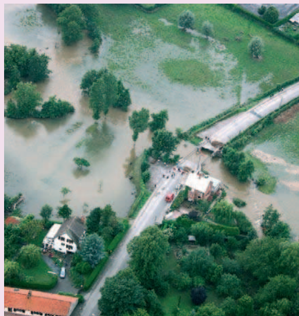
Le pont de Clerques emporté par la crue le 13 août 2006.
