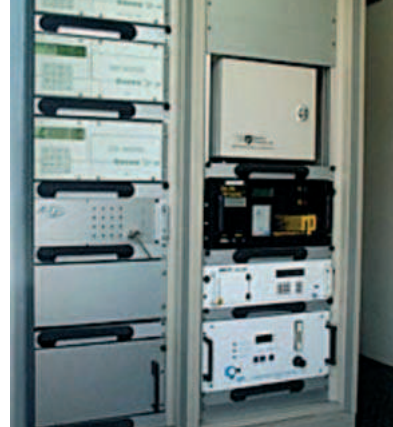
Station fixe de mesure de la qualité de l'air.
