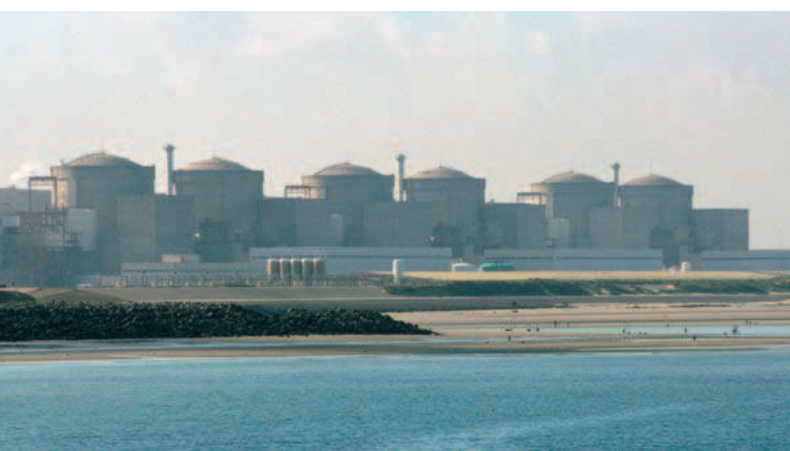
Le centre nucléaire de Gravelines.
