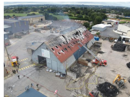
ARIA 65042 - Incendie centre TTR déchets métalliques (source photo: SDIS 50)
