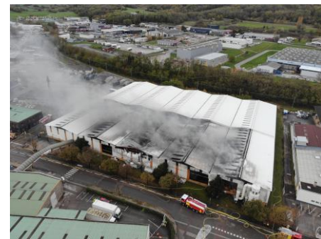
ARIA 61522 : Incendie centre TTR DEEE (source photo: SDIS 39)
