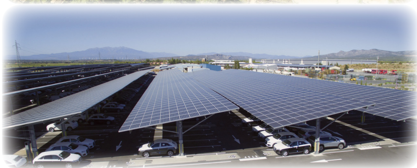
Ombrières de parking
