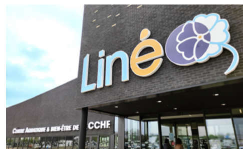
le centre aquatique intercommunal Linéo à Wormhout
