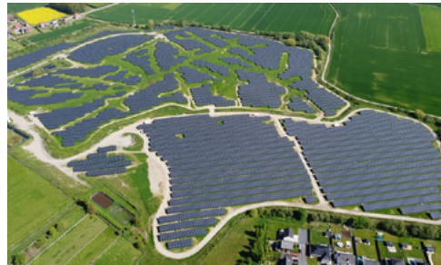
la centrale photovoltaïque de Leforest
