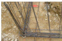
Noeud de chaînage - Continuité mécanique
