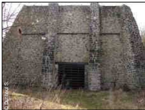
● Ancien four à chaux de Baives, site CSN 59-62
