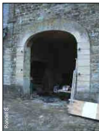
Bâtiments du Château de Souverrain Moulin à Pittefaux (62)
