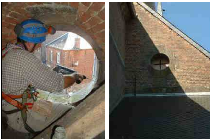
Figure 9 : Aménagement d'une lucarne sur l'église de Maroilles (59) avec le PNR Avesnois (Jacubek G.)
