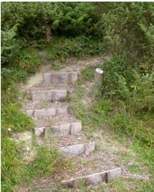
Création d'escaliers (©CEN)
