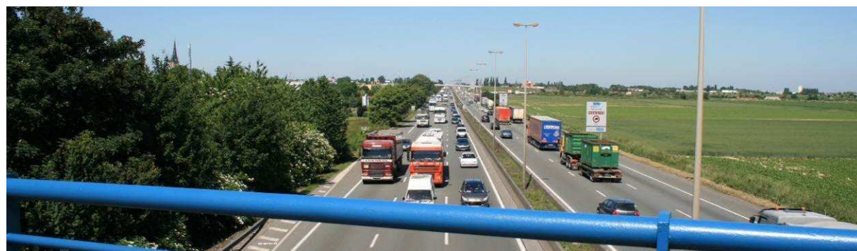
Photographie 1. L'emprise du mur antibruit se trouve le long de l'autoroute sur la gauche de la photo
