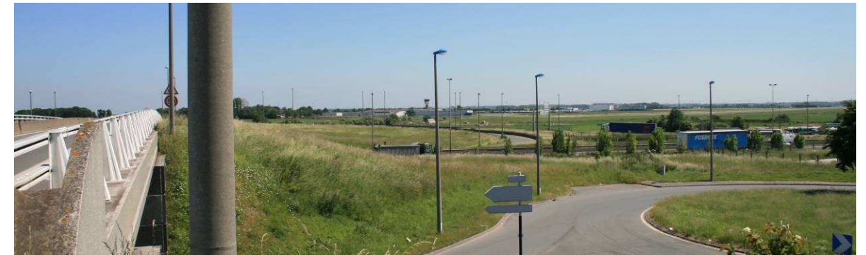
Photographie 1. L'emplacement prévu pour le déplacement de la bretelle d'insertion
