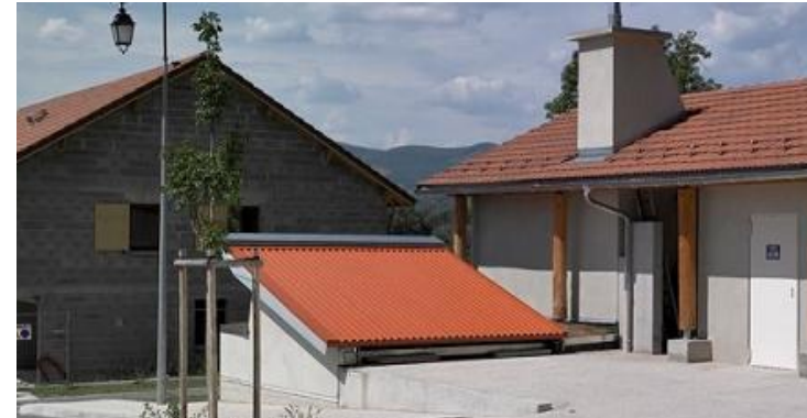
Chaufferie bois La Rivière (38)
