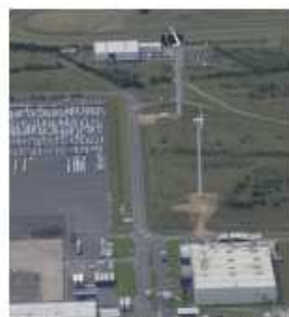
Développement en ponctuation - Usine Nissan - GB
