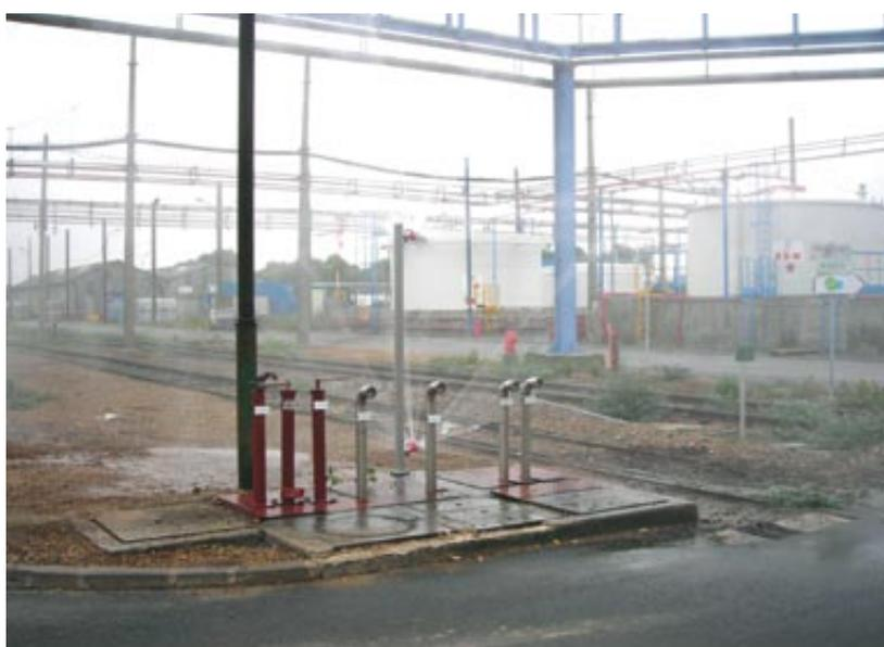
**Protection des vannes incendie et branchements mousse par un système de queues de paon**
