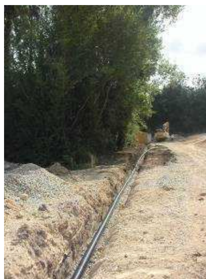
Pose d'un drain
