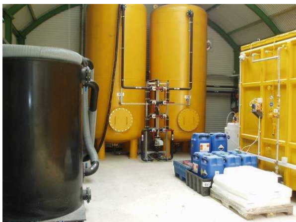
Station de traitement des eaux drainées
