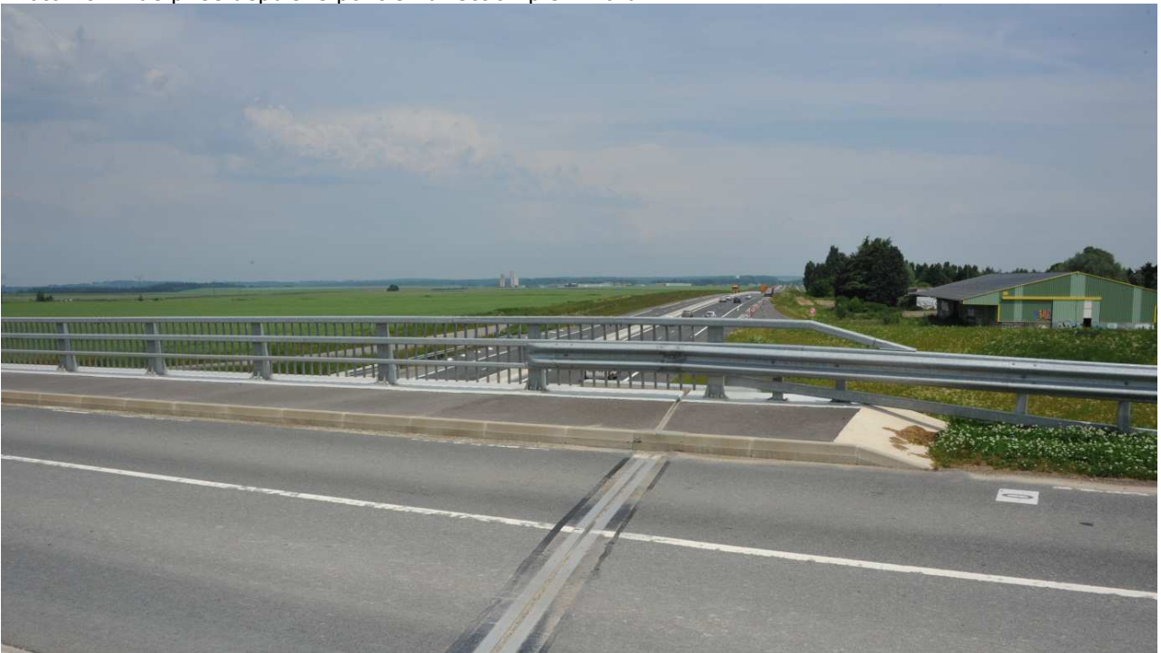
Photo 10 - Vue prise depuis le pont en direction plein Nord.
