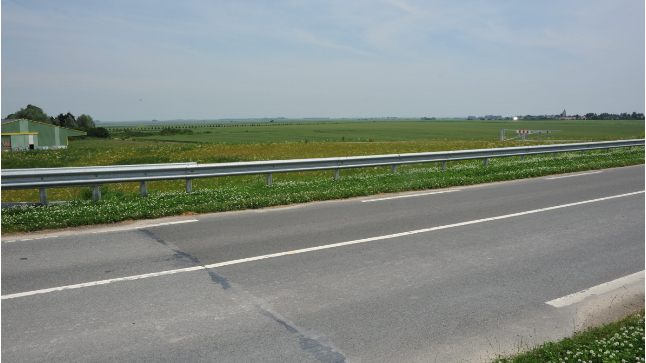
Photo 11 - Vue prise depuis le pont en direction plein Ouest
