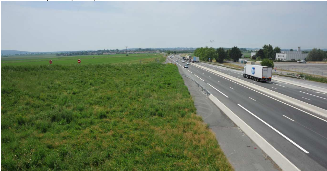
Photo 7 – Vue prise depuis le pont vers le Sud-ouest dans l'axe de la RN2.
