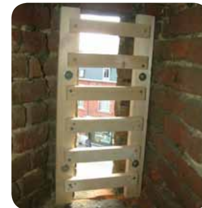
Le grillage qui obturait cette meurtrière a été remplacé par ce dispositif en bois. L'écartement entre les barreaux laisse passer les chauves-souris et interdit l'accès aux pigeons. Il s'agit d'un aménagement simple et à moindre coût.
