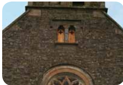
Les fenêtres de ce clocher, dont les vitres étaient totalement hermétiques au passage des chauves-souris, ont été remplacées par des panneaux de bois avec accès aux chiroptères intégrés.
