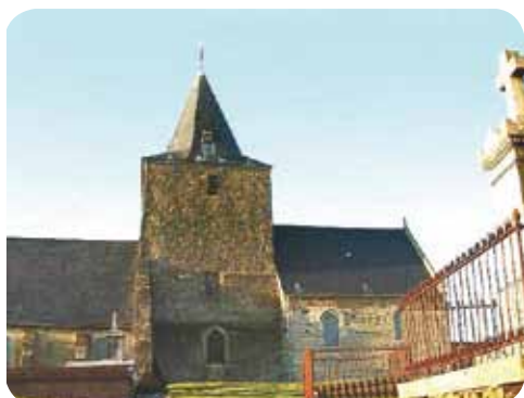
L'église de Bazinghen, où une colonie d'oreillard roux a été découverte lors des inventaires de 1998-99, a été mise en protection et aménagée en faveur des chiroptères.
