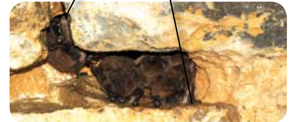
Ce pont de pierre a été « parfaitement » rejointoyé sur toute sa longueur. Seule une petite partie de dix centimètres a été « oubliée ». Ce qui permet à quatre murins à moustaches de s'installer pour l'hiver.
