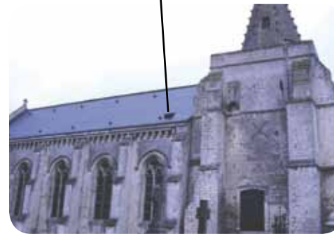
La chiroptière permet de créer un accès aux combles en vol. Une réfection de toiture peut être l'occasion de la créer. Cette ouverture doit être large d'au moins 40 cm, haute de 7 cm maximum et si possible exposée à l'ouest en raison des intempéries.
