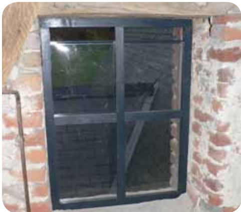
Sur cette église classée aux Monuments historiques, une ancienne fenêtre située dans les combles et donnant sur le pignon arrière a été reconstruite à l'identique. La surface vitrée laisse un accès de 6 cm de haut pour les chauves-souris.
