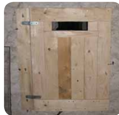
L'installation d'une porte en bois (pourvue d'un passage pour les chiroptères) entre les combles et le clocher présente plusieurs intérêts : cela diminue la luminosité dans les combles et limite les dérangements pour les chauves-souris (porte fermée à clefs et panneau d'information installé sur la porte).
