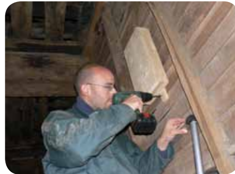
Pose d'un gîte en bois dans un clocher
