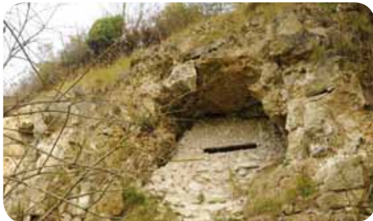
Les anciennes carrières de Cléty
