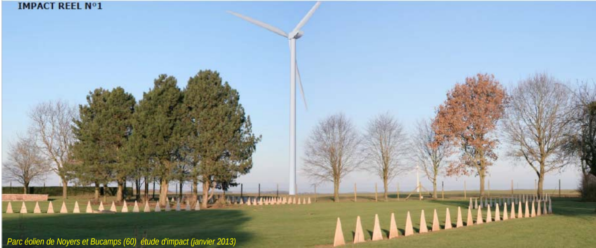
Parc éolien de Noyers et Bucamps (60) étude d'impact (janvier 2013)
