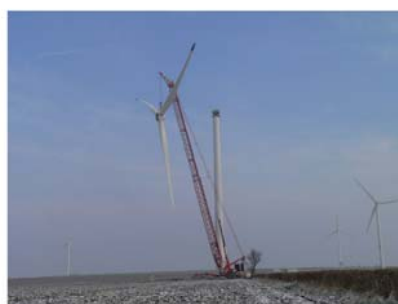
Montage d'un parc éolien (Source : Ventura)
