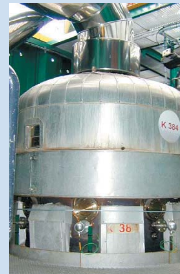
Installation de traitement du N 2 O chez CLARIANT (par réduction catalytique)
