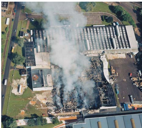
Photo aérienne de la Société COFRANLAIT à Doullens lors de l'incendie du 8 juillet 2002.
