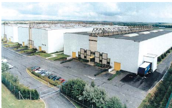
Entrepôt LOCARCHIVES à Péronne (80)
