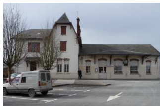
Point d'arrêt de Guignicourt (Aisne)
