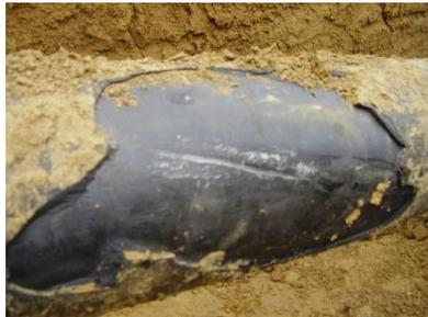
Lors d'un chantier de VRD pour la création d'une ZAC, le godet de la pelle hydraulique a griffé la canalisation.
