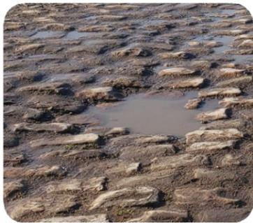
Concrètement, ces situations peuvent causer la casse ou le déchaussement d'un ou plusieurs pavés, créant des nids de poule ou trous dans la chaussée.
