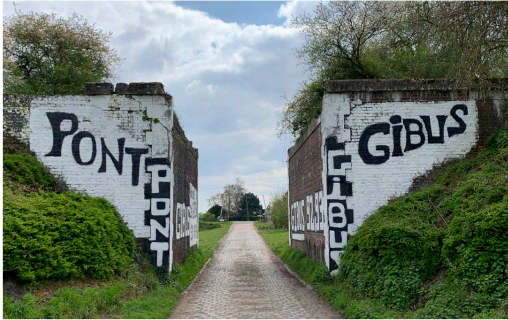
Le pont Gibus est un ouvrage d'art en brique à chaînage d'angle en pierre. Cet ancien pont ferroviaire faisait partie de la treille minière et servait au transport du charbon. Le tablier a disparu, et il ne reste désormais que les deux piles maçonnées ceinturant l'axe pavé emprunté par la course du Paris-Roubaix (et le Tour de France en 2022).
