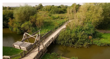
Pont levé à l'entrée de la RNN. (Eden62, 2019)
