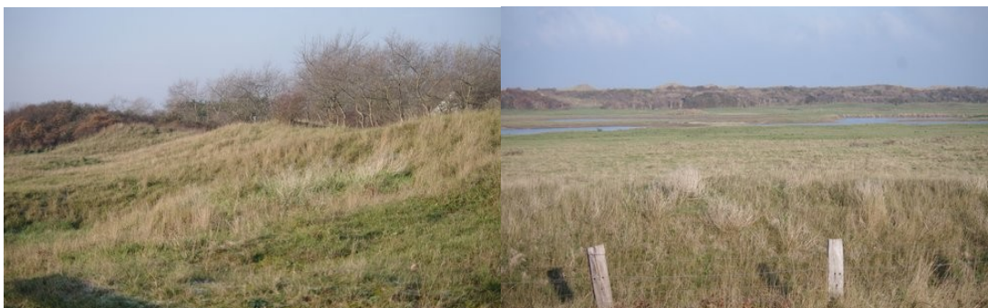
Figure 59 : Digue TAAF sous la végétation (à gauche : en face du parking des Ecardines, à droite : en face du Polder central) – Source : Eden 62, 2018
