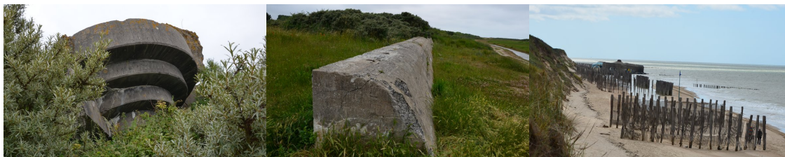
Figure 34 : Photographies de bunkers et du mur antichar se trouvant dans la RNN - Source : Eden 62
