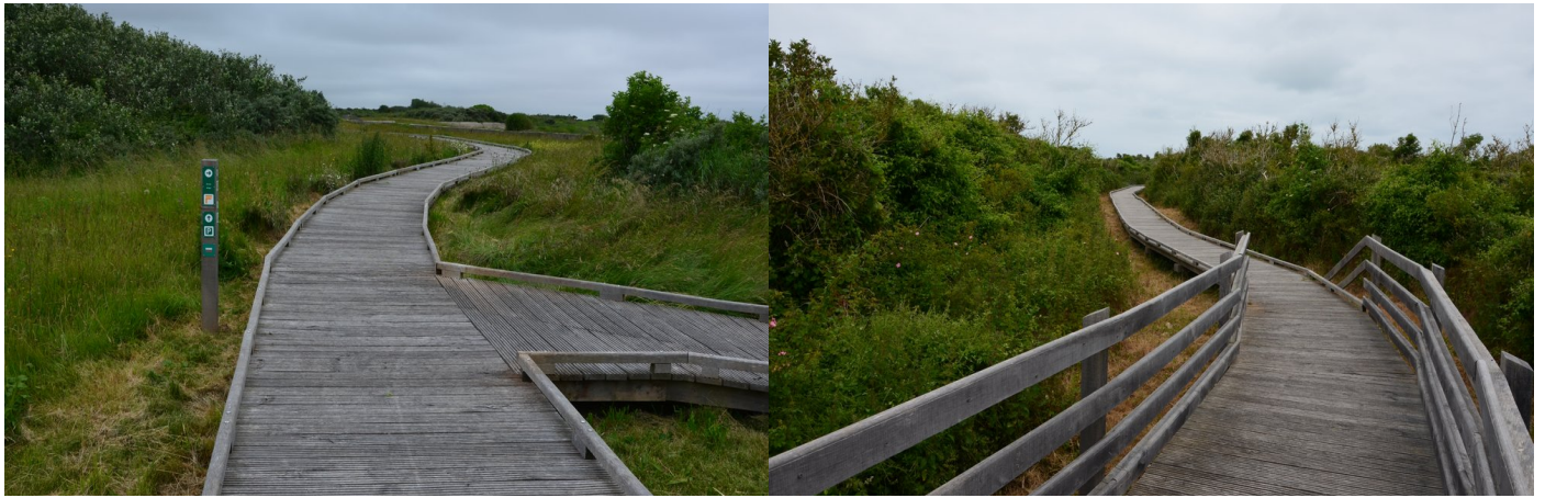
Figure 43 : Platelage aménagé - Source : Eden 62, 2018
