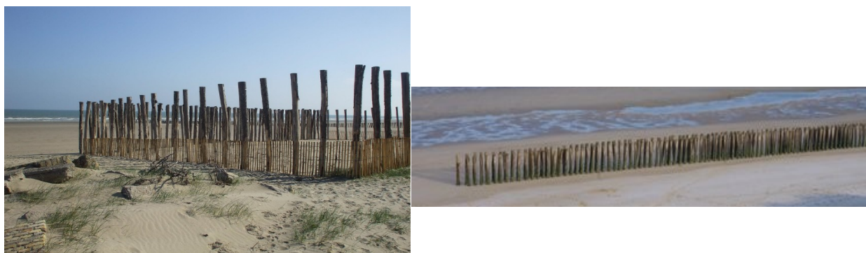
Figure 10 : Photographies d'un casier à sable (à gauche) et du brise-lames (à droite) pour accumuler le sable et protéger le cordon dunaire de l'érosion marine – Source : CCRA, 2016 – Eden 62, 2018
