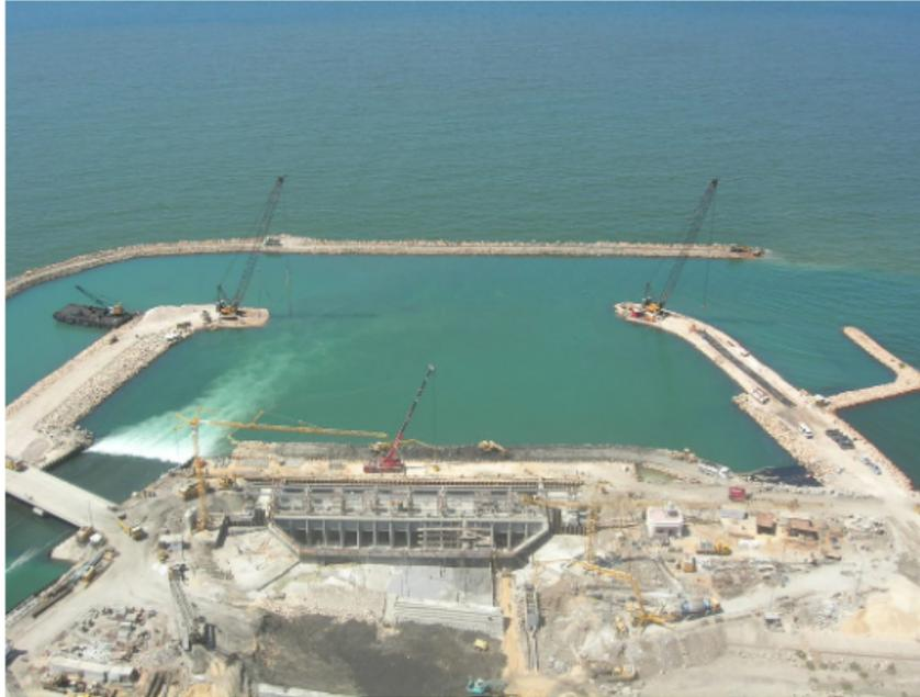
Les brise-lames peuvent être situés au large ou reliés au littoral et protègent généralement les infrastructures maritimes de l'action des vagues et des courants. Le brise-lames dissipe l'énergie des vagues au large, générant des bassins d'eau calme de manière à ce que les activités portuaires puissent être menées à bien en toute sécurité.
