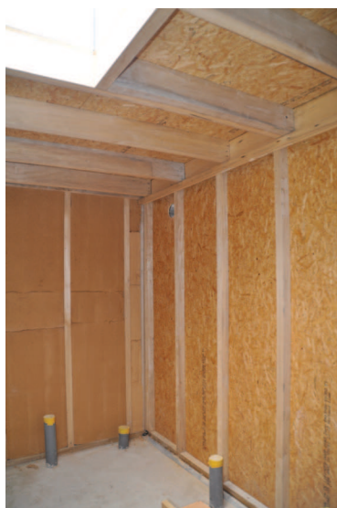
Ossature bois en peuplier (Actes architectures)
