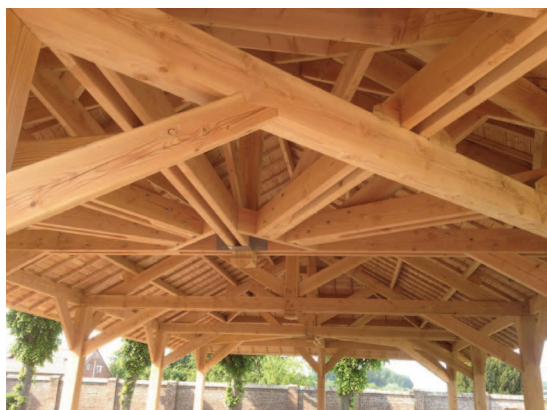
Charpente Douglas du marché couvert de Honne-court sur Escaut (charpenterie des Hauts de France)
