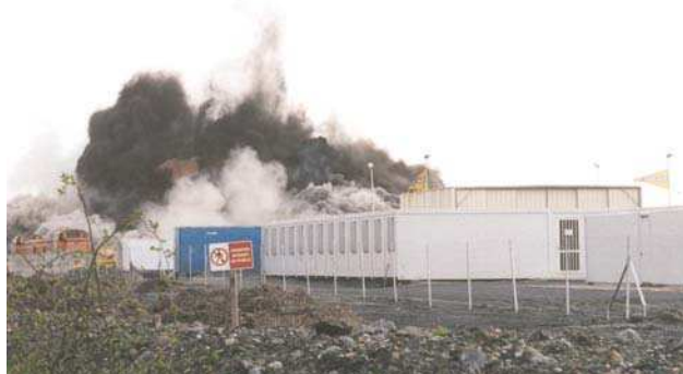
Démolition d'une friche sur le site de Douges.
