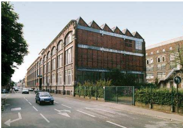
Friche Roussel à Roubaix avant réhabilitation.
