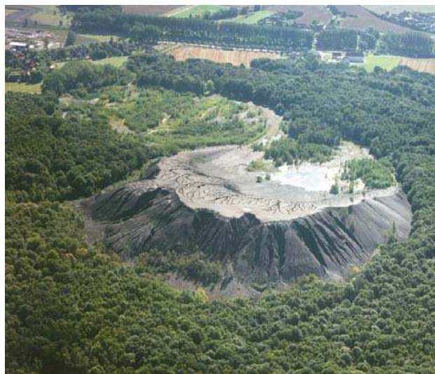
Le terril de Bruay-Labuissière avant réhabilitation (1994).
