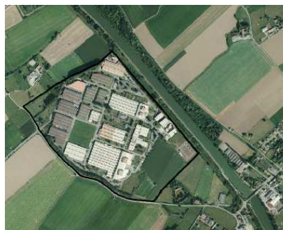
2014 Ancien site Arc Internationa l (Blaringhem)
