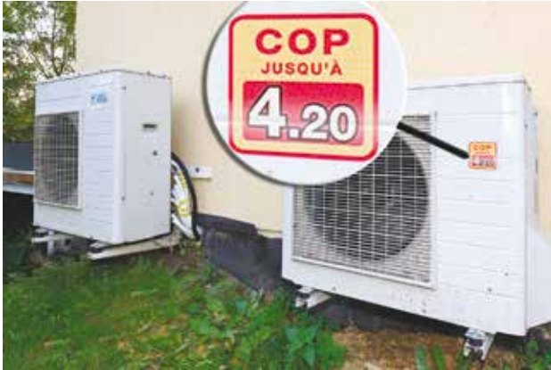
Le COP et l'efficacité énergétique réels sont toujours inférieurs à ceux mesurés dans des conditions bien définies en laboratoire.
