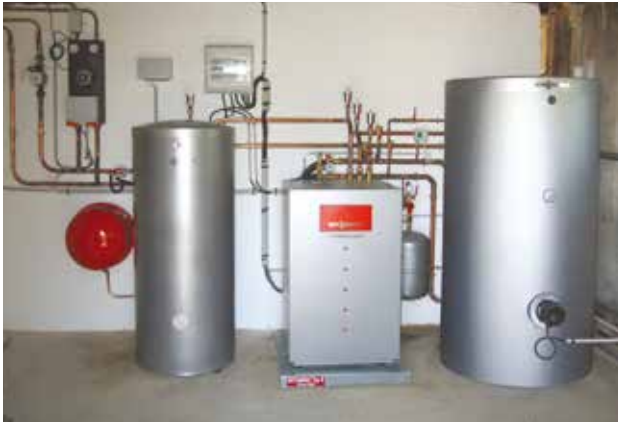
Pompe à chaleur géothermique reliée à un ballon tampon pour le chauffage et à un ballon d'eau chaude sanitaire.
