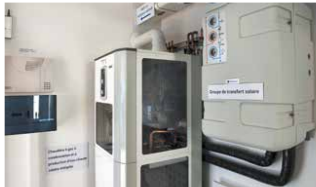
Cette chaudière à condensation au gaz est couplée à une installation solaire pour la fourniture d'eau chaude.
