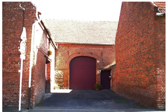
Ferme au n°12 rue du Centre avec grange présentant un porche remarquable visible depuis l'espace rue
