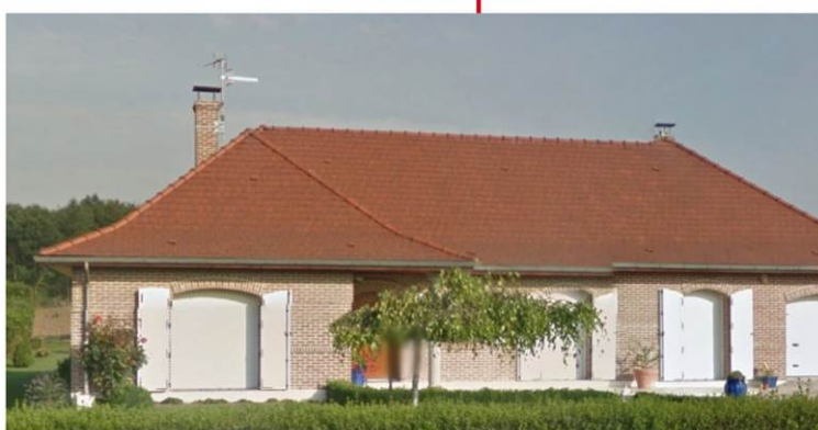
Habitat pavillonnaire R+C en retrait de l'espace public. Architecture de brique et couverture en tuile mécanique rouge orangé.
