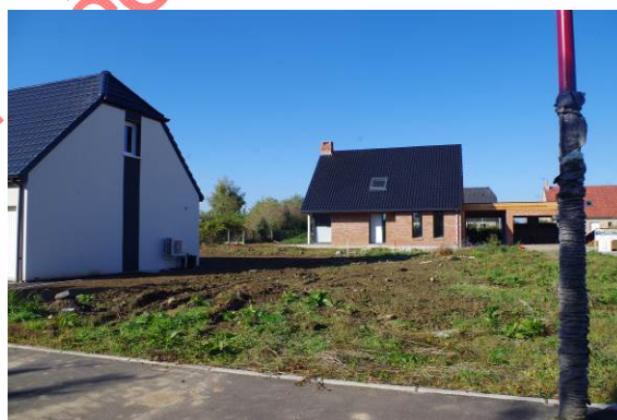
La commune a connu un développement de son parc de logement ces dernières années
