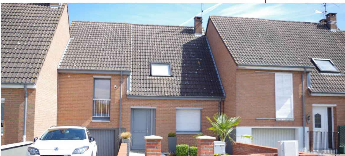
Habitat récent R+C avec garage semi-enterré. Les décalages de façade permettent une diversité de volume intéressante.
