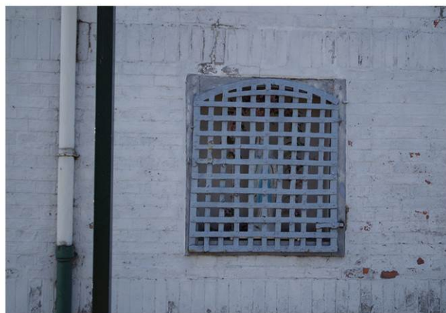
Oratoire avec grille dans une façade au n°37 rue du Centre.
