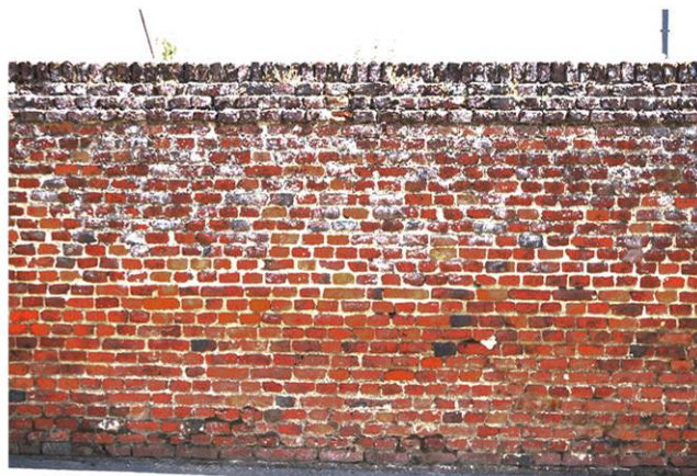
Mur remarquable avec couronnement en redans de brique sur la parcelle n°575 rue du Bout d'Epinoy
